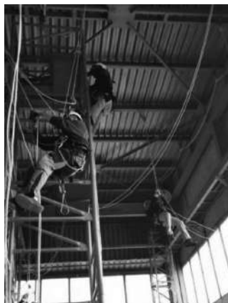
Фиг. 2 Монтажна работа
