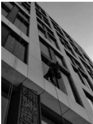
Фиг. 1 Почистване на фасада
