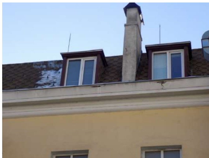
мълниезащитна инсталация
