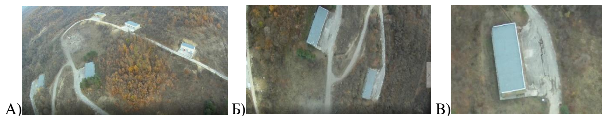
Фиг. 15 Заснемане на обектите с повишен интерес непосредствено до взривения склад: А - перспективен изглед на зоната на взрива; Б – съседни на взрива помещения; В – покрив на най-важният склад
