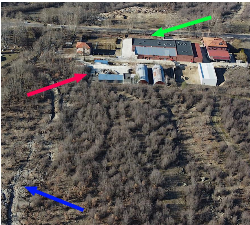
Фиг. 4. Поглед към север, демонстрираш оформянето на ново речно корито (сини стрелки), местото където временния поток е навлезнал в стопанските постройки (червена стрелка) и локацията на унищожената ограда на обекта (зелена стрелка).
