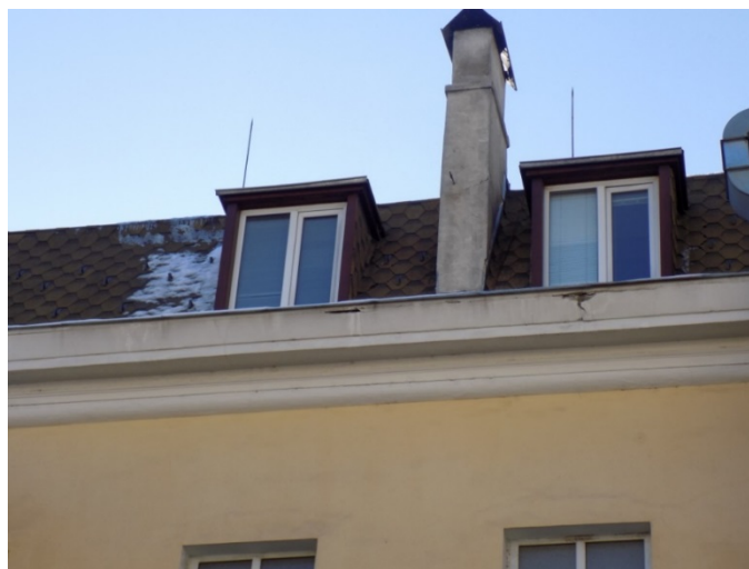
мълниезащитна инсталация
