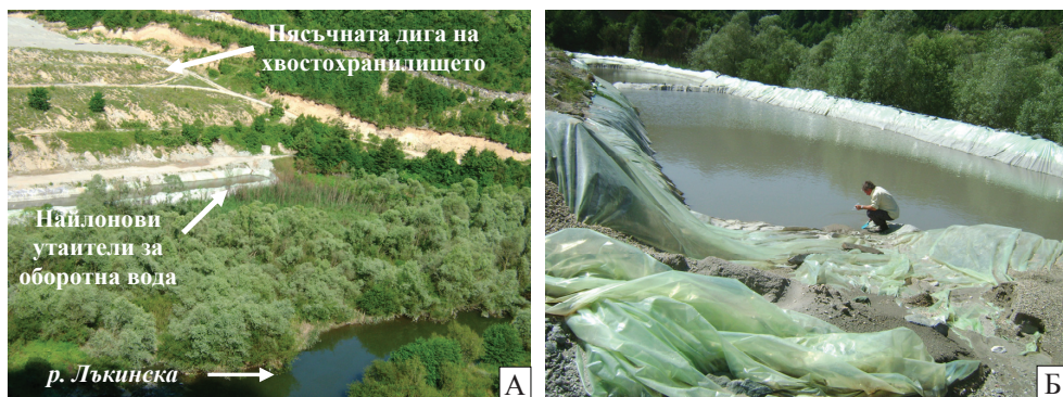
Фиг. 5. А – местоположение на найлоновите утайтели: под пясъчната дига на хвостохранилището и над река Лъкинска; Б – опробване на утайка и оборотна вода от найлоновите утайтели (проби W-2 и P-2)
