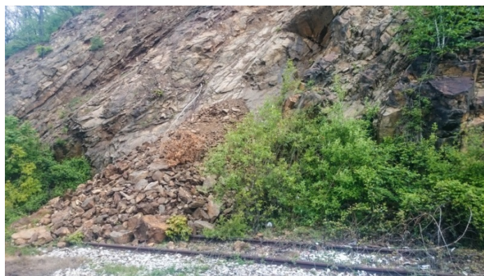
Фиг. 32. Срутване на неустойчива скална маса върху ж.п. линията София-Варна в района на гара Копривщица, западно от тунел „Козница“. Наклонът на фолиацията и по-късните крехки разломни зони съвпадат с наклона на склона и са потенциална опасност от нови свличания. Поглед към север.
