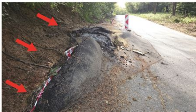
Фиг. 20. Свлачищни процеси в района на гр. Правец, по главния път Правец-Етрополе, където бяха наблюдавани свлачане и литификация на неустойчиви глинести и пясъчливи скали, нарушили асфалтовата покривка.
