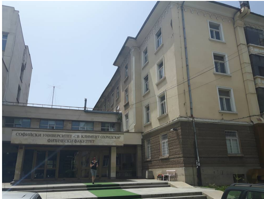
Снимка 1 – фасада североизток и топла връзка с Корпус А към фасада югоизток
