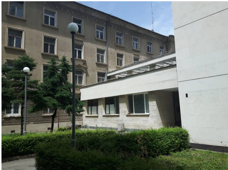
Снимка 10 – фасада югоизток голямо крило и топла връзка с Корпус А
