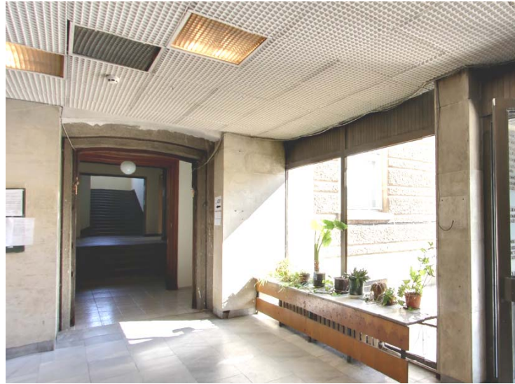
Снимка 11 – входа към сградата от към топлата връзка с Корпус А
